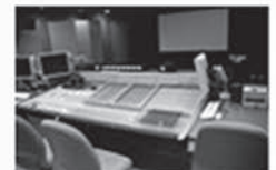
▶ スタジオシステム工事
